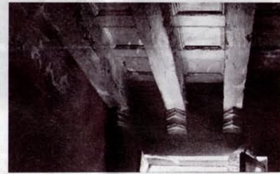
FORJADO con alfarje en el techo de la entreplanta. / E.C.
